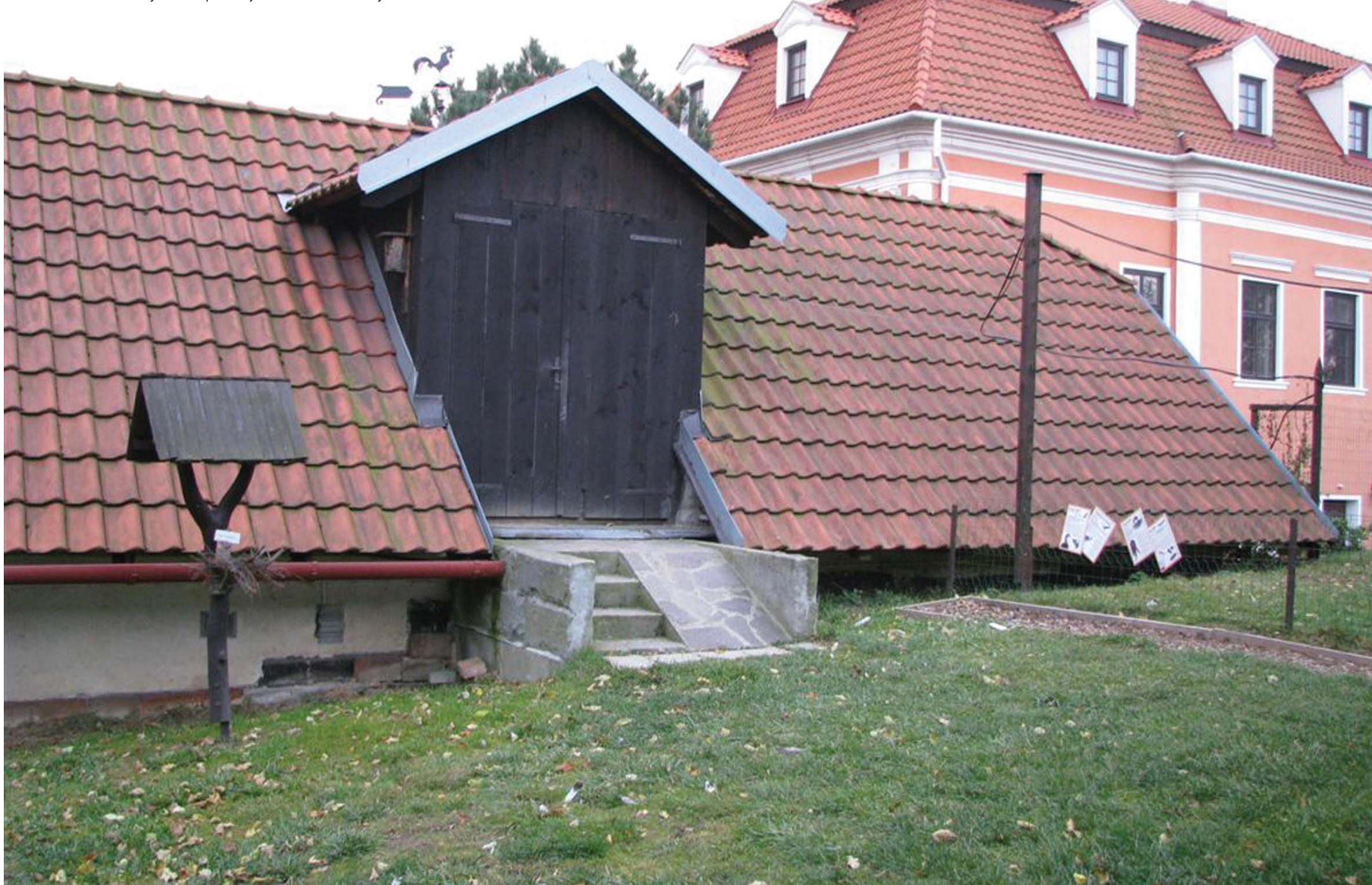
Současný stav: Pohled na budovu budoucí DPP od severovýchdu. V pozadí je barokní budova fary.
